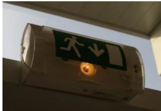
La sécurité incendie répond à la norme des ERT et ERP en vigueur. Chaque sortie est équipée d'un BAES et les pièces de formation et de réunion sont équipées d'un éclairage ambiant de sécurité. Une sortie de secours est prévue dans la salle de conférence et un système de désenfumage complète la sécurité incendie.
