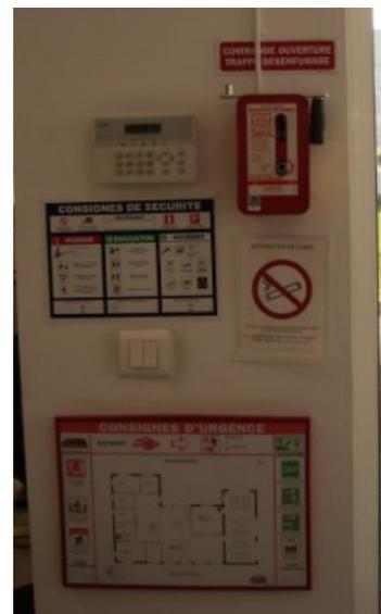
Le bâtiment FORMATECH est protégé par une alarme de type SIEMENS (conforme à la norme NFA2P - type 2) avec 5 zones distinctes (salle de conférence ; local traiteur et réserve ; salles de formation 1, 2 et 3 ; bureau studio d'enregistrement et local technique ; avec usage des parties communes et la pièce de décharge) et 3 claviers de commande.
