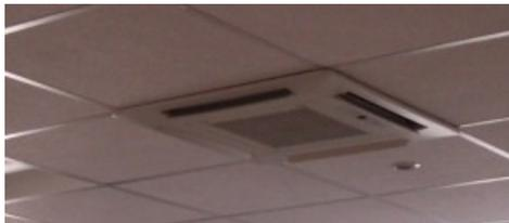
Le chauffage et la climatisation sont assurés par des groupes pompes à chaleur pour chaque bâtiment. Chaque unité est programmable individuellement par télécommande.
